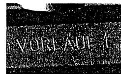
Beschriftungen Vorlauf und Rücklauf sind im verzinkter Stahlblechmantel eingepresst.
