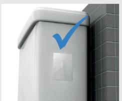
Das Pflaster wird nach ca. 15 - 30 min ausgehärtet sein (je nach Temperatur der Umgebung). Die Schadstelle ist jetzt abgedichtet und für Druckstärken bis 7 bar belastbar.
