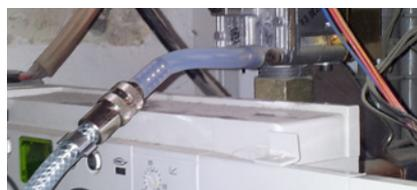
Gebrauchsfähigkeitsprüfung mit dem Adapter über die Gastherme
