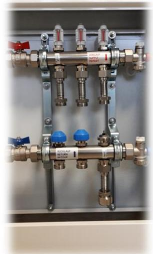
Der Einbau, muss durch eine fachlich geeignete Person erfolgen. Die Armatur muss spannungsfrei eingebaut werden. Insbesondere beim Anziehen der Überwurfmutter sind Torsionskräfte zu vermeiden. Hierzu ist mit geeignetem Werkzeug, an den Schlüsselflächen gegen zu halten.
