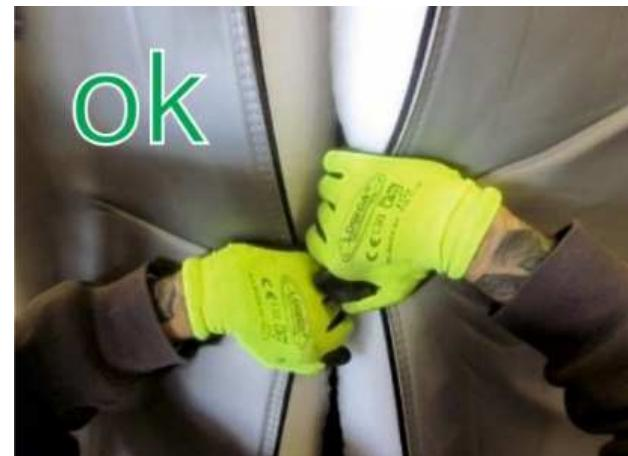
Dans un montage correct, la distance entre les extrémités de la fermeture éclair est à quelques centimètres. Fixer la fermeture éclair en haut et, alors que l'opérateur tient ensemble les deux parties, l'autre tire la fermeture vers le bas. Vous devrez peut-être appuyer avec la paume de votre main pour rendre l'isolation bien adhérent au réservoir
