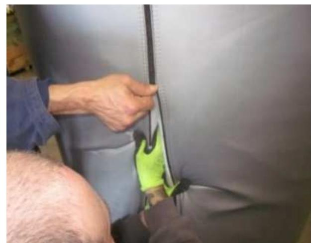
**EMPFEHLUNG:** Verwenden Sie keine Zange oder mechanische Werkzeuge, um den Reißverschluss zu verschließen. Bei niedrigen Temperaturen kann es möglich sein, den Reißverschluss nicht in einem Schritt zu schließen. Warten Sie bis die Isolierung sich erwärmt hat. In schwierigen Situationen können Sie auch nach der Montage den Behälter erwärmen, um die richtige Temperatur zu erreichen und dann den Reißverschluss fertig schließen.
