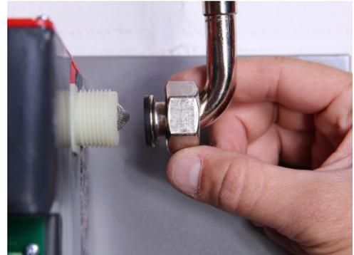
Visser l'écrou de serrage en face du robinet d'arrêt monté dans la conduite d'eau potable.
