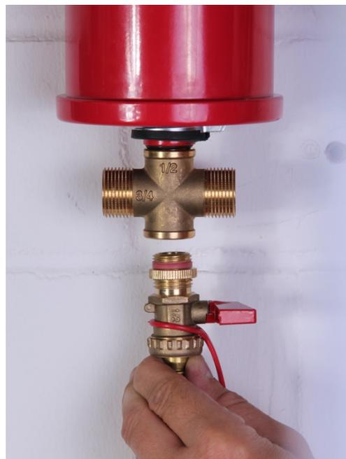
Ensuite, la vanne d'arrêt sur conduite de départ vers les points utilisateurs avec manomètre sera reliée à l'écrou de serrage à joint plat et au raccord en T. (Sur le site le raccord du manomètre sera scellé sur la vanne d'arrêt sur conduite de départ vers les points utilisateurs.)
