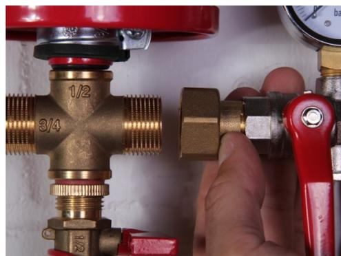
Le tuyau flexible relie la connexion de pression de la pompe et le raccord en T du vase d'expansion.
