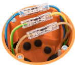
Leiter in Abzweigdose verbinden.
