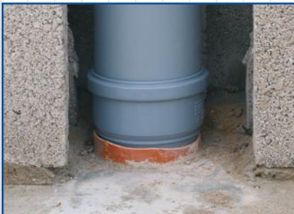
Mit der **Airfit** Steckmuffe kann schnell und einfach eine neue Muffe durch Einstecken – einer Steckmuffe – ins Rohr geschaffen werden.
