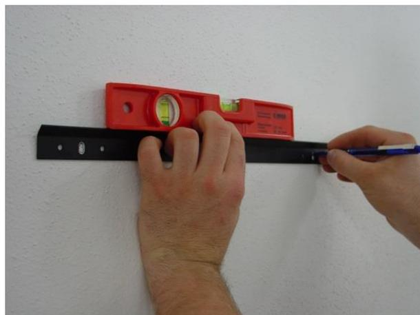
Hängen Sie das Gerät an der zuvor montierten Schiene an die Wand. Achten Sie darauf, dass die Winkelschiene ordentlich sitzt und das Gerät in der horizontalen Ausgerichtet ist.
