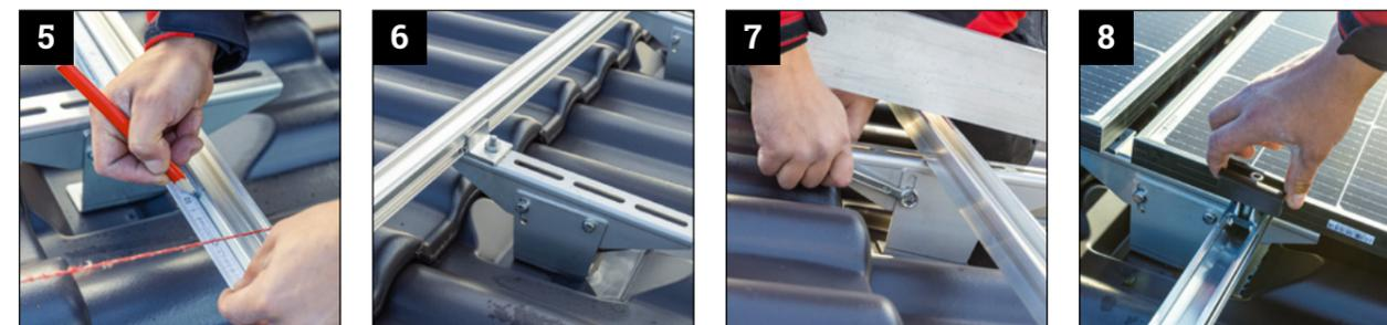
**5** Une fois que toutes les tuiles de support solaires sont posées, vous pouvez fixer la structure porteuse de l'installation solaire sur les supports solaires en acier VA.
