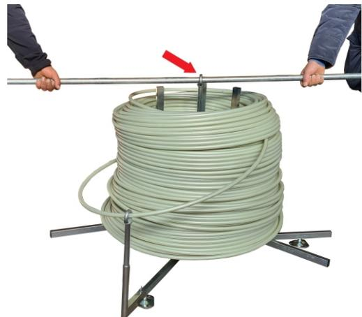
6) Per spostare il rotolo sul cantiere, Infilare un'asta nell'apposito occhiello e spostarlo in due persone.
