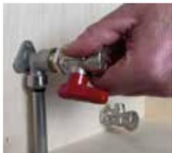
Installation facile. Serrage à la main. Aucun outil ni matériel d'étanchéité n'est nécessaire.
