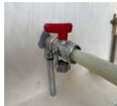
L'Eurocône côté sortie permet de connecter tous les tubes les plus courants avec des raccords à compression !
