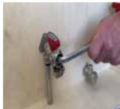
La vanne KFE permet une fixation avec une clé 6 pans, évitant ainsi d'endommager l'extérieur.
