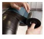
Wrap wird einfach mit einer Überlappung von 20 mm um das gedämmte Rohr
