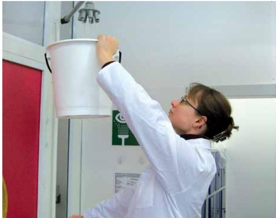
Personalintensiver Wasserwechsel an jeder endständigen Entnahmestelle. Heutzutage übliche, aber ineffektive und teure Lösung, um den bestimmungs-gemäßen Betrieb im Gebäude sicherzustellen.
